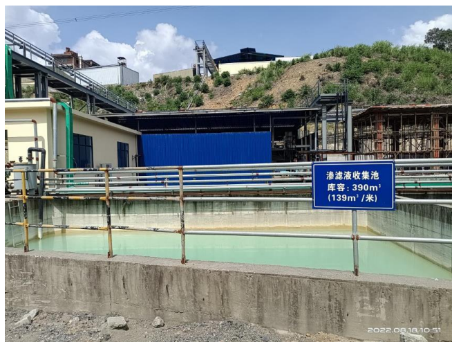
图 4.9-3 吉朗钢业渗滤液收集井和收集池
