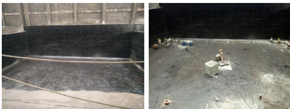
图 4.9-5 外购危险固废储存库地面防渗
