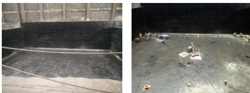
图 5.4-8 外购危险固废储存库地面防渗
