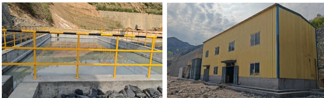
图 4.9-4 南方公司内渗滤液收集池和处理站
