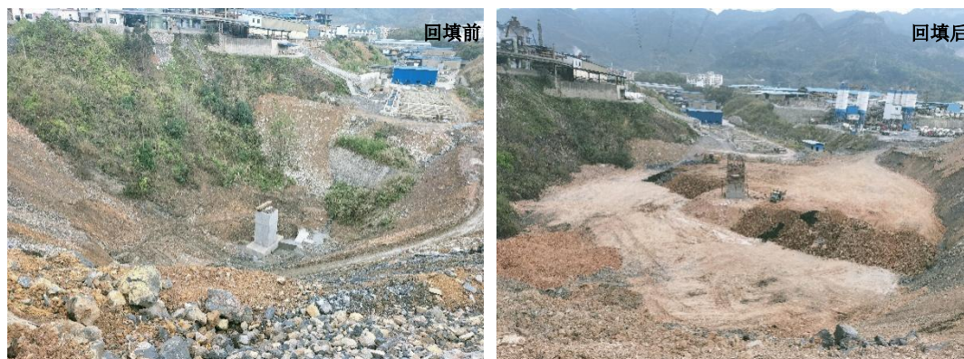
图 4.9-6 金山涵洞口渗滤液收集池
